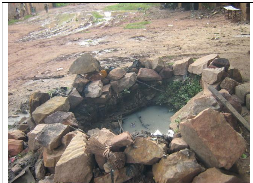
Photo 2 : Un puisard à ciel ouvert dans une rue à Djicoroni Para
